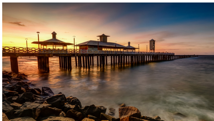
Figura 9 – Ponte dos Ingleses - Fortaleza(CE)
