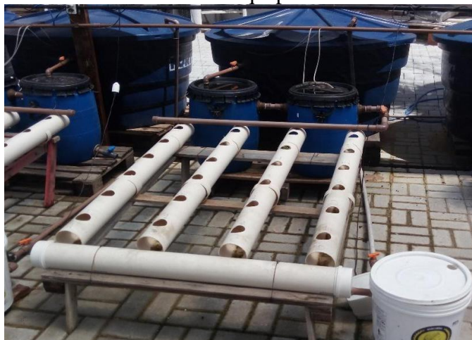
Figura 04 - Exemplo de um dos sistemas de cultivo utilizados no tratamento Aquaponia.
